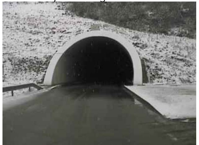
Tunnel Trojane Lenght 300m
