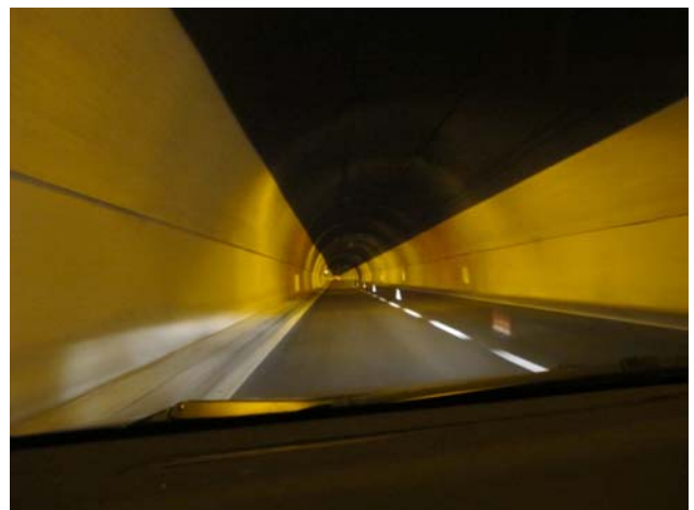
Novejši ali obnovljeni italijanski predori, ki so osvetljeni po novem principu, kjer so svetila zastrta in praktično ne vidimo izvora svetlobe, predor pa je kljub temu zelo kvalitetno osvetljen, mnogo bolj varni in omogočajo varno vožnjo tudi starejši populaciji voznikov nad 40 let.
