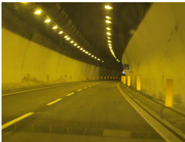
Običajno osvetljen nekoliko starejši italijanski predor Gran Sasso dolžine nad 10km s številnimi svetili na stropu.
